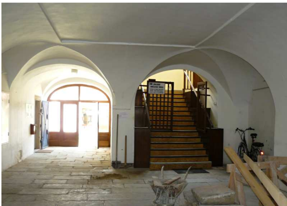
Vlevo vchod do knihovny, vpravo po schodišti do ZUŠ
