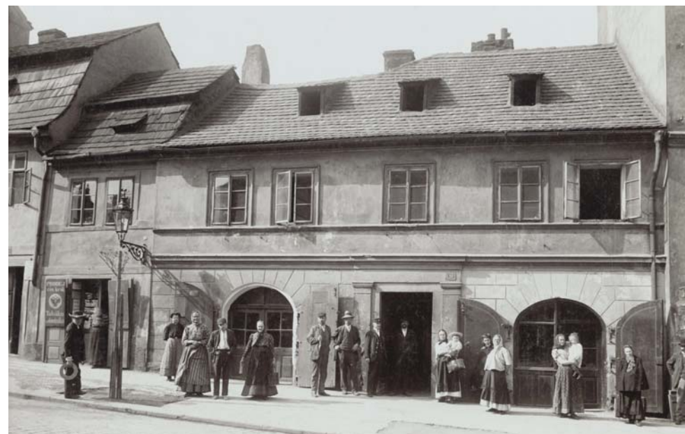
Celkový pohled na průčelí domu čp. 30 ve Vratislavově ulici na Vyšehradě.
