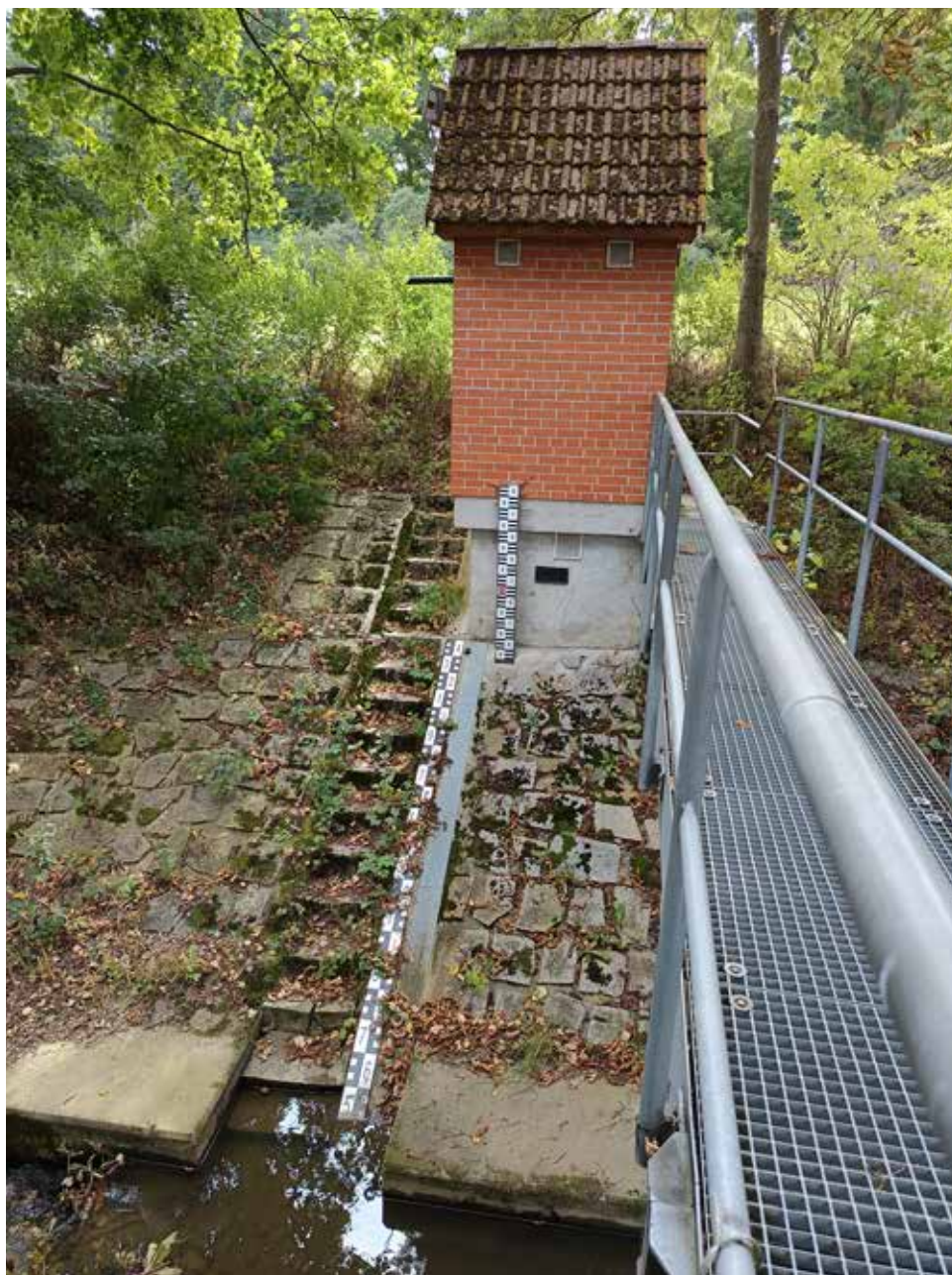
Obrázek 27 Vodoměrná stanice v obci Příštpo
